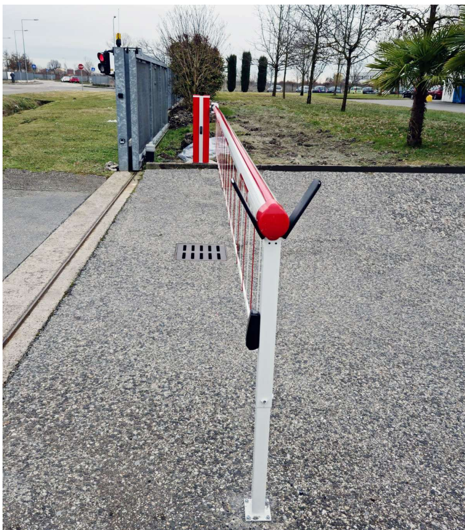
Figura 2. Chiusura tipo FAAC B680H (installazione immagine n. 02).
