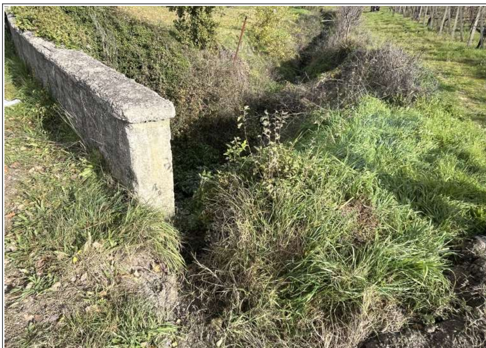
Figura 7 - Tratto del Torrente del Ruoti visto da monte interessato da erosione. Si nota la spalletta del ponte di Via della Madonna delle Rose.
