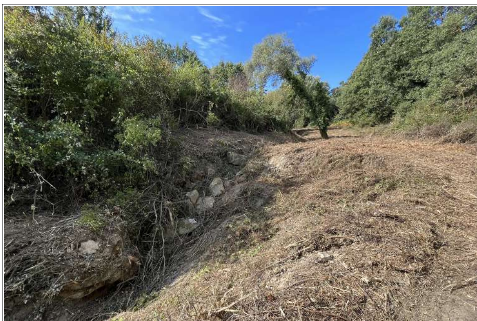
Figura 2 - Tratto del Fosso Cavernano interessato da erosione e smottamenti (vista da nord).
