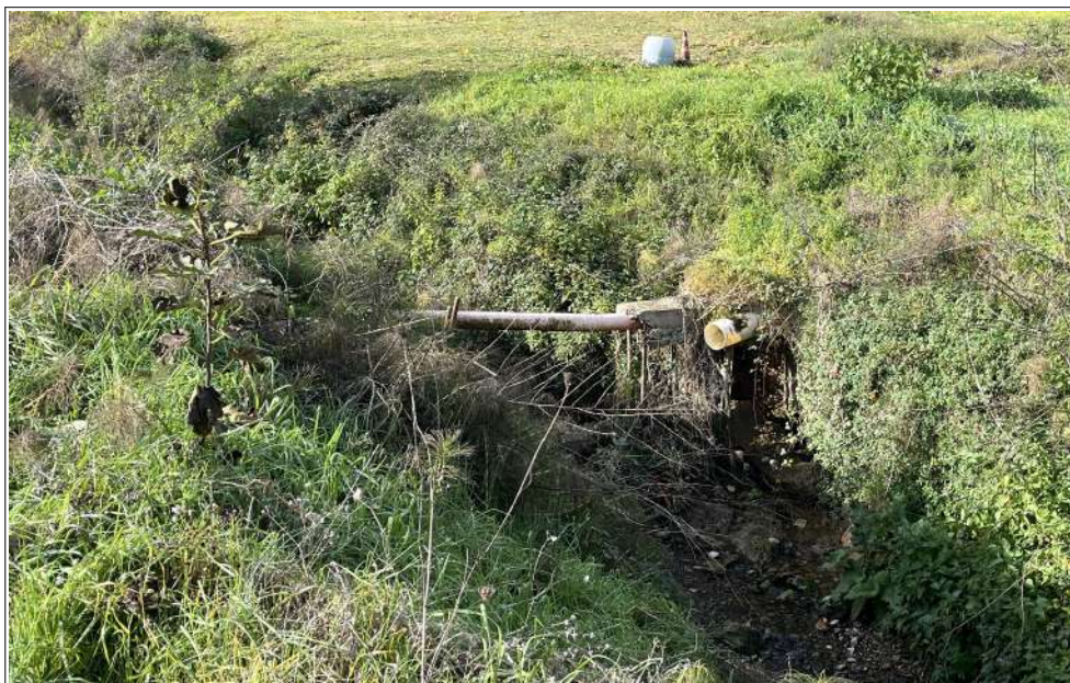
Figura 14 - Immagine (da valle) del tubo in PVC di attraversamento e del tubo di immissione sulla sponda sinistra.
