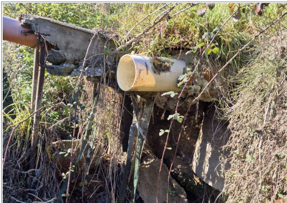
Figura 15 - Particolare della foto precedente del tubo in PVC di immissione sulla sponda sinistra.
