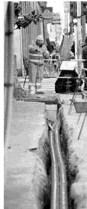
Lavori per la sistemazione delle fibre ottiche
