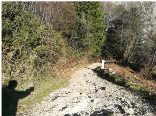
**Figura 136: forte erosione incanalata sulla strada
