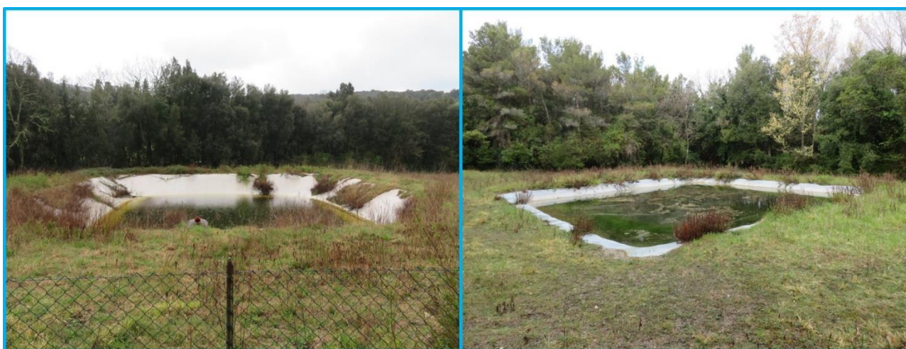
Figura 8.8 - I due invasi AIB che attualmente sono non operativi.
