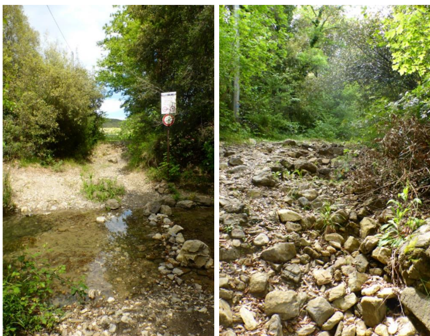
Figura 8.19 - Condizioni attuali della viabilità oggetto di ripristino.
