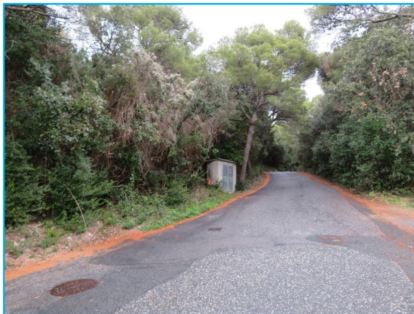
Figura 8.6 – Idrante nella zona di Quercianella.
