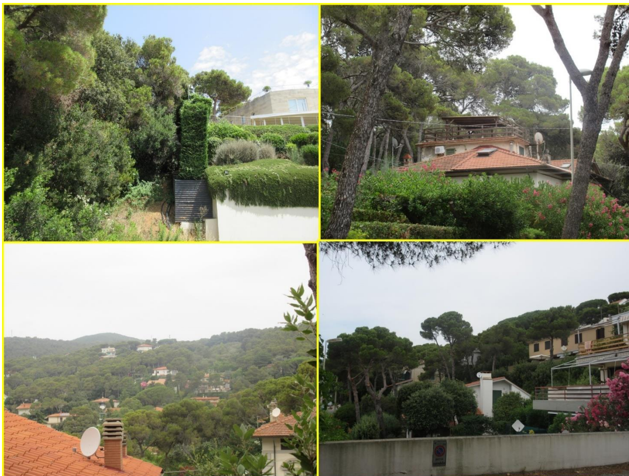
Figura 8.11 – Zone di interfaccia urbano-bosco con molte strutture che in caso di incendi boschivi risulterebbero indifendibili.
