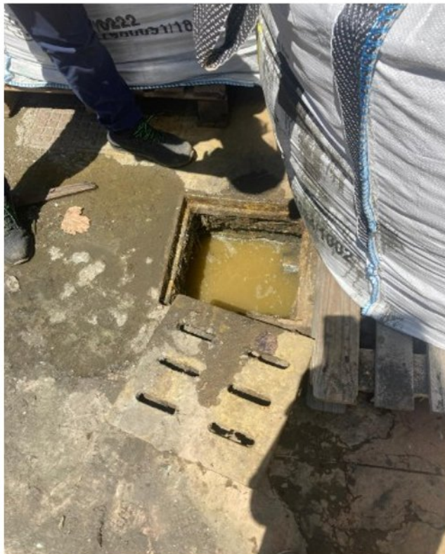
Foto 12 - POZZETTO denominato POZZETTO A4 con copertura a griglia, sito a circa 7 metri dal pozzetto A3 nel resede esterno posteriore della ditta DANY, sul quale poggiano i big bags contenenti rifiuti aventi codice EER 120116*. Tale pozzetto ha una sola immissione ed è ubicata sul lato est. Proseguendo la videoispezione su tale tubazione si è individuato un nuovo POZZETTO denominato POZZETTO A5, posto nella proprietà della ditta SERENI S.r.l.
