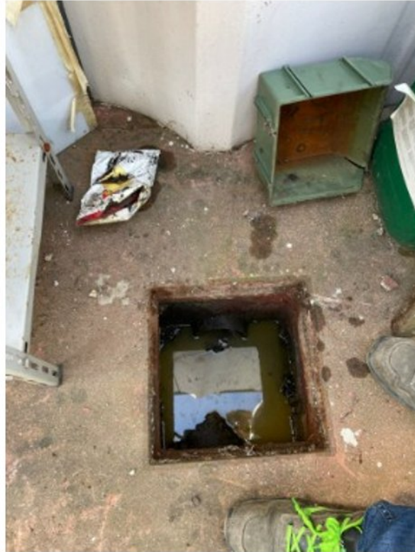
Foto 17 – POZZETTO denominato POZZETTO A5, sito sul resede esterno posteriore della ditta SERENI S.r.l. che raccoglie esclusivamente le acque provenienti dalle grondaie del tetto della ditta SERENI S.r.l., collegato con il POZZETTO A4, con coperchio metallico pieno.
