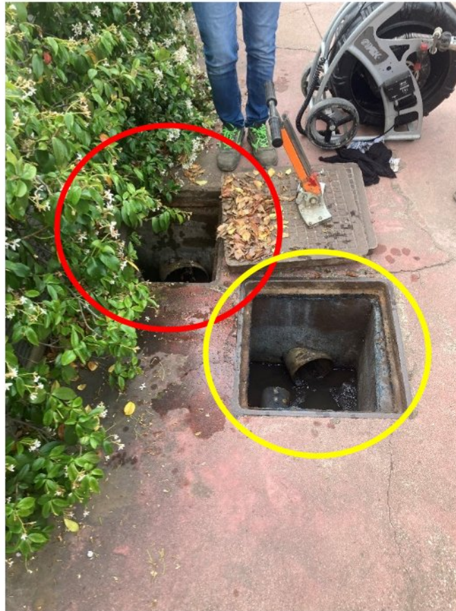
Foto 3 – Cerchiato in ROSSO: POZZETTO ACQUE METEORICHE denominato POZZETTO A1, sito nel piazzale interno della ditta DANY S.r.l. vicino al confine della ditta SERENI S.r.l.; cerchiato in GIALLO: POZZETTO ACQUE NERE così denominato.
