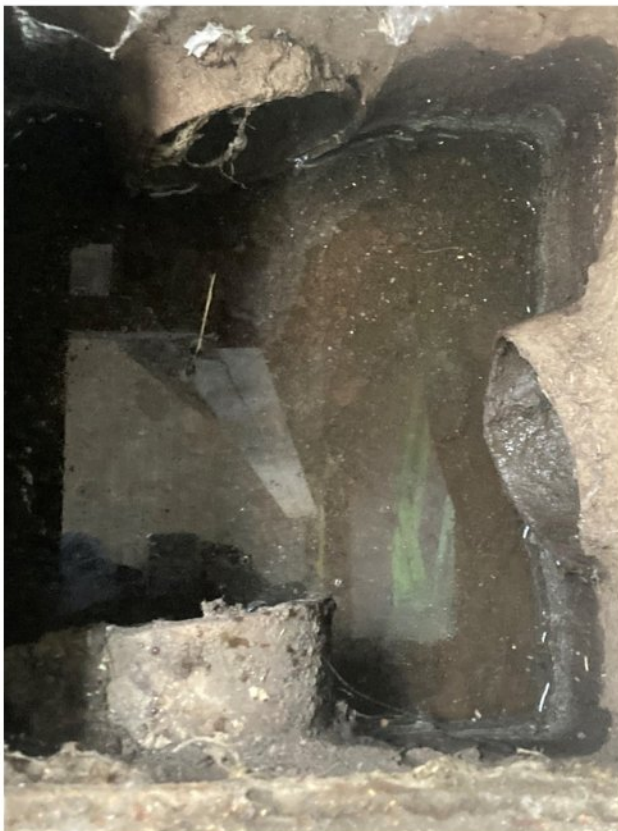
Foto 6 – Particolare del POZZETTO A2, con visibile iridescenza sulla superficie dell'acqua.
