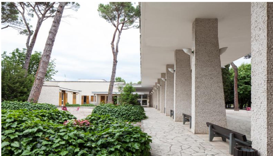
Tettoie biglietteria locali- Parco Acquasanta
