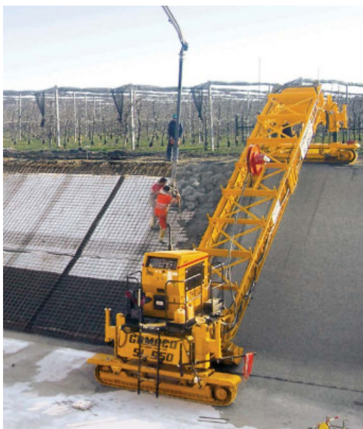
Figura 48: Esempio di posa di rivestimento in cls mediante macchina pavimentatrice
