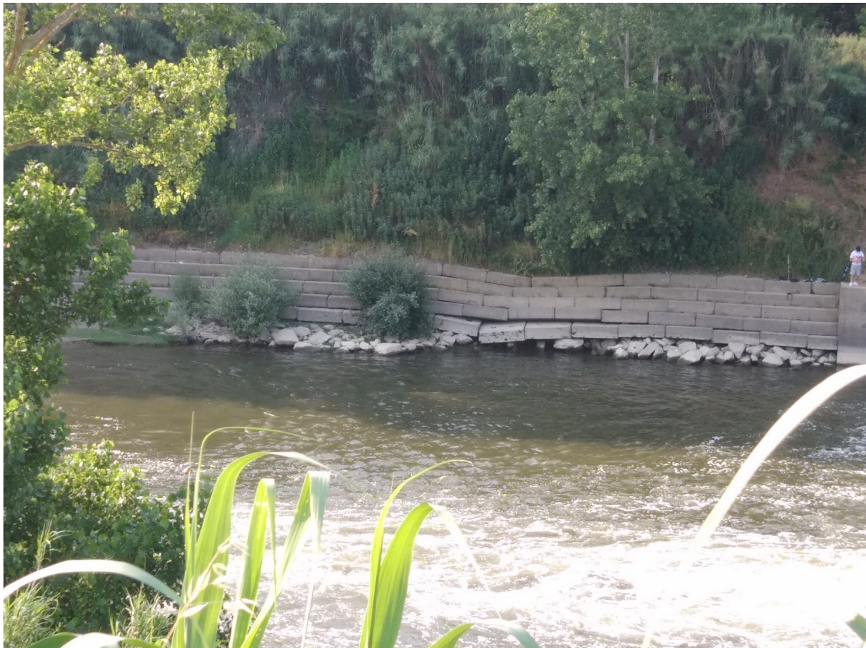
Figura 2.6 - Tratto a valle della traversa della cartiera: è evidenziato il punto in cui la scogliera è stata asportata, con il conseguente cedimento al piede dell'opera di difesa spondale
