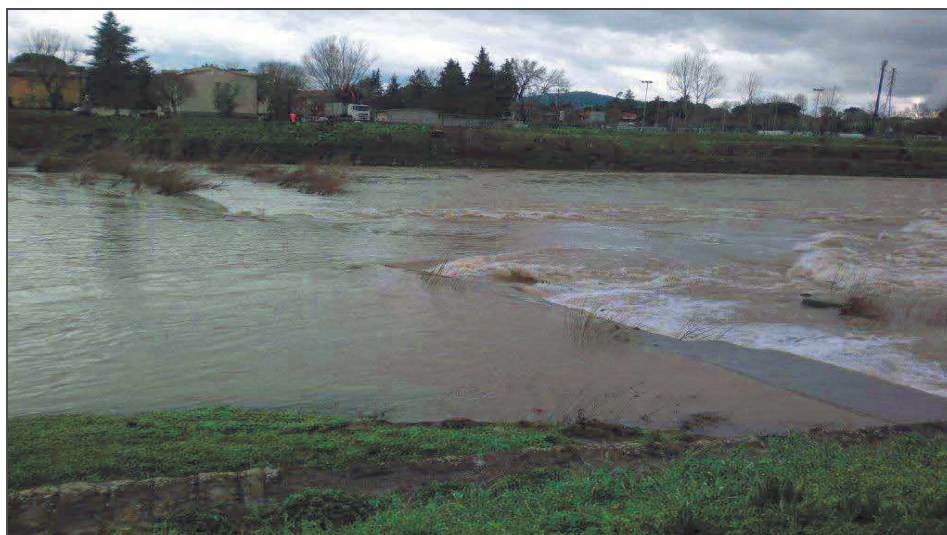
Figura 4 – Pescaia dei Massetti (dopo la rimozione)
