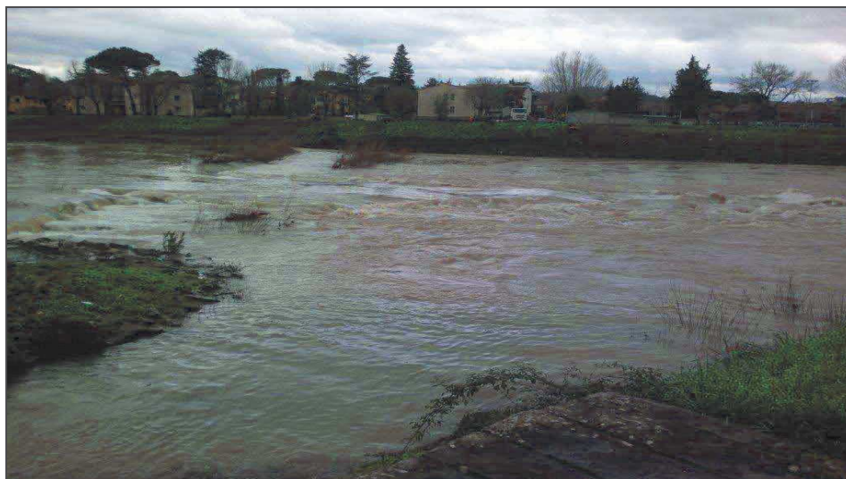
Figura 5 – Pescaia dei Massetti (dopo la rimozione)
