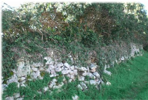
*Figura 26 – Muretti a secco non mantenuti*
