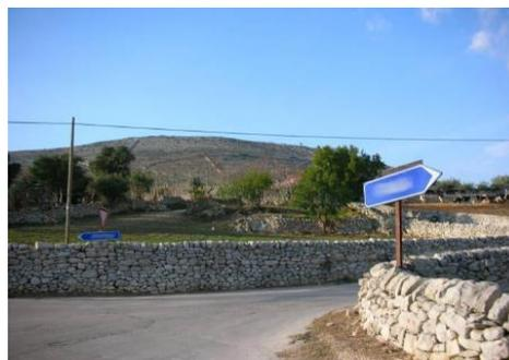
*Figura 25 – Muretti a secco mantenuti*
