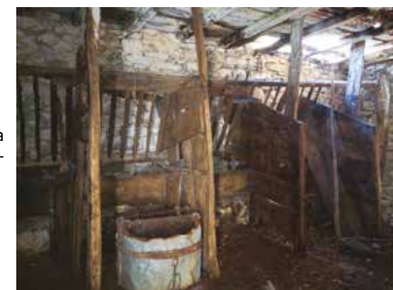
Fig. 21 Vallaspre, interno a piano terra della stalla adibita ai bovini con 5 postazioni in legno.
