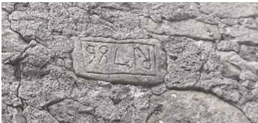
Fig. 28 Quartiana, data 1786 preceduta da iniziale R murata capovolta nella facciata della casa.
