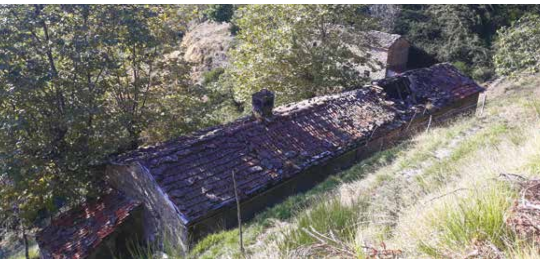
Fig. 17 Vallaspre, l'abitazione stretta e allungata e, sullo sfondo, la stalla.
