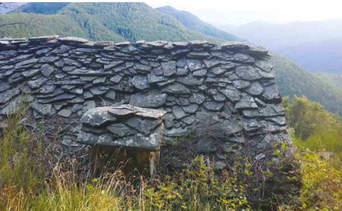
Fig. 12 Alpeggio di Boiana, particolare del tetto in lastre di arenaria con il comignolo.
