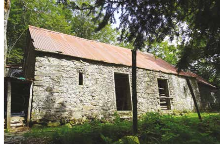
Fig. 25 Le Coste, ovile con tetto in lamiera sostituito l'originario in paglia di segale.
