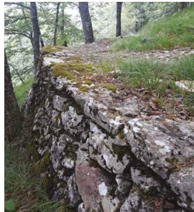
Fig. 54 La via dell'alpe di Corfino verso Campaiana, particolare della massicciata a secco di sostegno alla carreggiata nei pressi di una curva.
