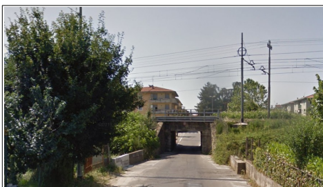
Sottopasso ferroviario in corrispondenza di via Salvadori
