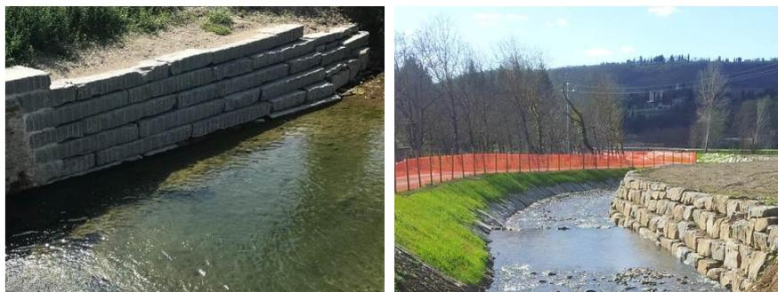
Figura 12: Esempio di muro in scogliera
