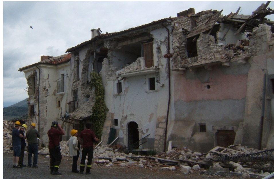
San Pio delle Camere – loc. Castelnuovo
