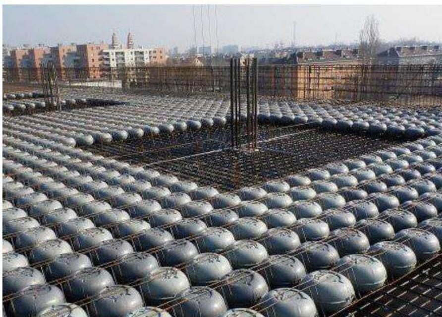
*Esempio di solaio a piastra alleggerito con elementi sferici in HDPE*
