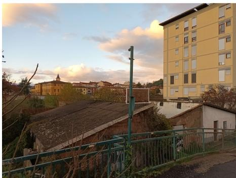
Copertura in amianto presente in fabbricati dell'aggregato A
