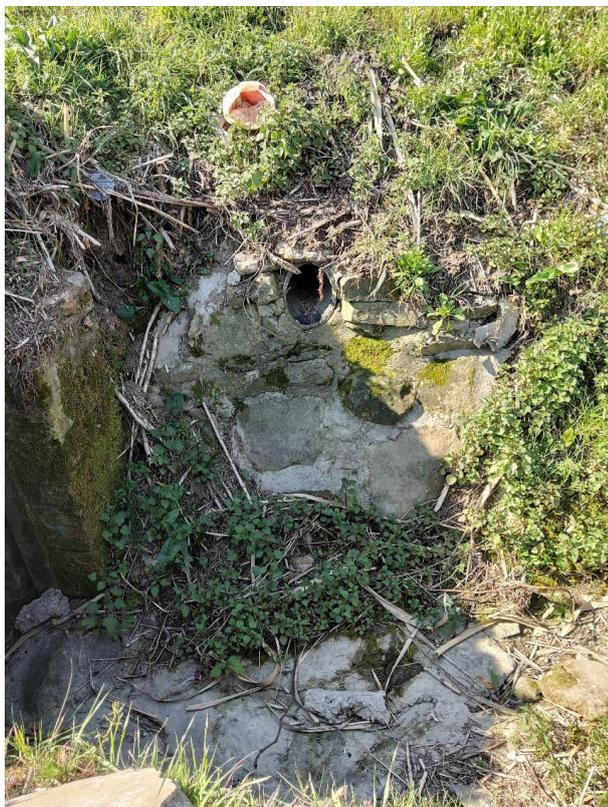
Foto 5 – Scarico della tubazione Pead DN 225
