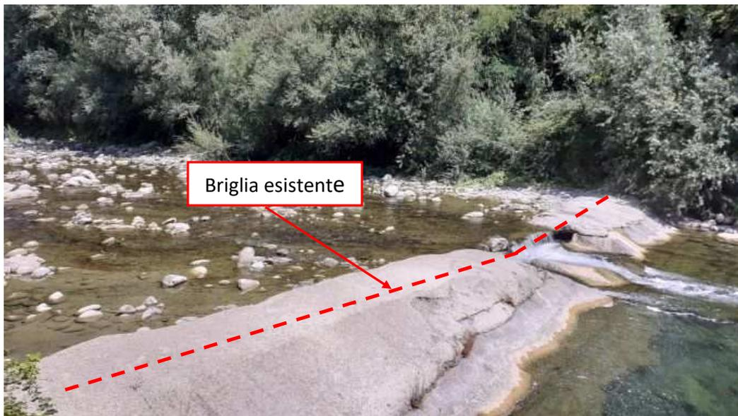
*Foto 2 – Particolare briglia da sostituire.*
