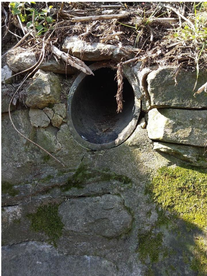
Foto 7 – Particolare scarico della tubazione Pead DN 225
