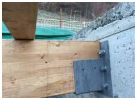
**Fig. 7.1.1.39 - Collegamento della nuova copertura in legno alla muratura perimetrale Minucciano (LU) - Fonte: portale sismica Portos**
