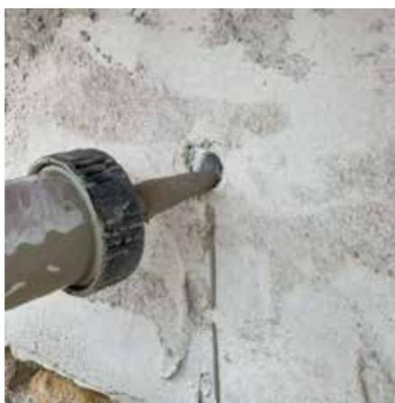
Fig. 7.1.2.44 - Particolare di inghisaggio del connettore Anghiari (AR) - Fonte: portale sismica Portos
