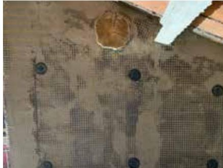
Fig. 7.1.3.2 - Collegamento tra paramenti murari, con materiali compositi
