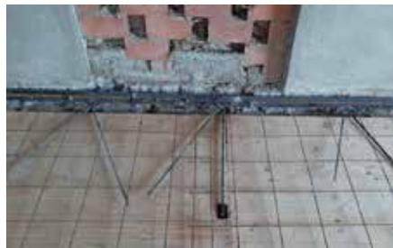
**Fig. 7.1.1.19 - Irrigidimento di solaio, con getto di cls alleggerito e rete elettrosaldata**
