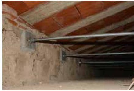
Fig. 7.1.1.45 - Riduzione della spinta dei travetti di copertura, con tiranti metallici effetto "capriata"
