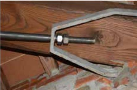
Fig. 7.1.1.48 - Collegamento di puntone alle murature d'ambito (particolare)
