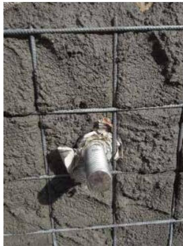
**Fig. 7.1.2.18 - Consolidamento muratura per appoggio della piastra capochiave**
