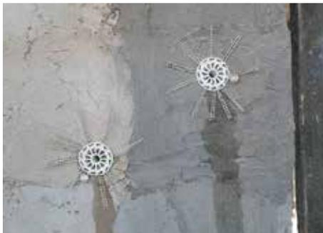
Fig. 7.1.2.37 - Placcaggio di cantonale, con fasce in materiale composito
