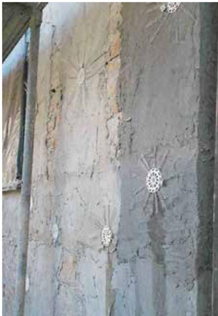
Fig. 7.1.2.38 - Placcaggio di cantonale, con fasce in materiale composito
