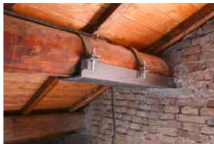
Fig. 7.1.1.55 - Collegamento di trave primaria alle murature perimetrali, mediante "bicchiera" metallico
