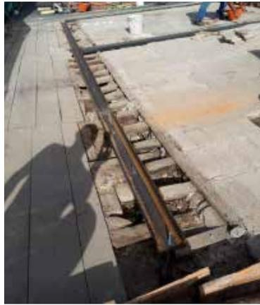
Fig. 7.1.2.51 - Cordolo in acciaio su muro perimetrale
