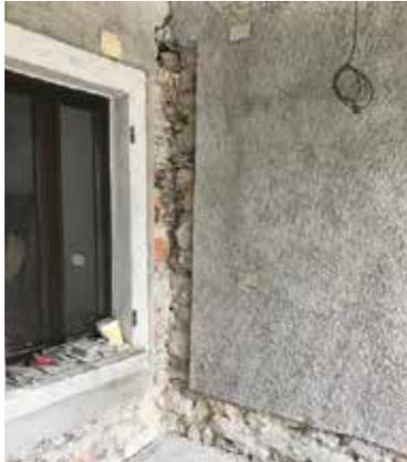
Fig. 7.1.2.7 - Connessione all'angolo, mediante angolari metallici - prima
