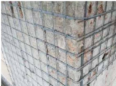
Fig. 7.1.4.7 - Consolidamento pareti, con betoncino armato e rete elettrosaldata
