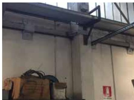
Fig. 7.4.2 - Collegamento dei pannelli di tamponatura alla struttura principale di capannone prefabbricato
