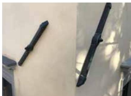
**Fig. 7.1.2.22 - Alloggiamento di paletti capochiave a collegamento tra pareti ortogonali**
