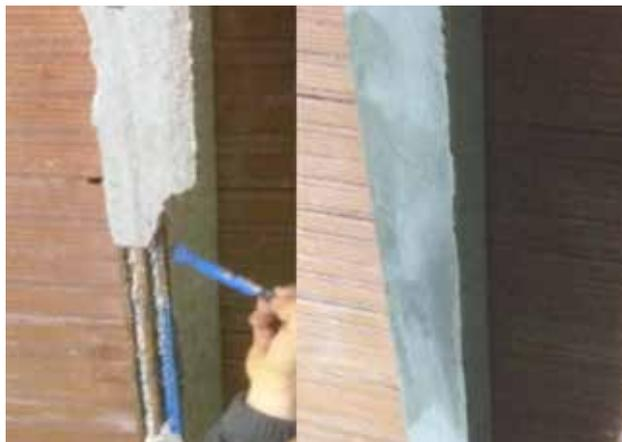
Fig. 7.1.1.32 - Consolidamento di travetto di solaio in c.a. ammalorato
