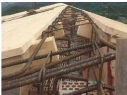
Fig. 7.1.2.57 - Cordolo in c.a. al colmo della copertura
