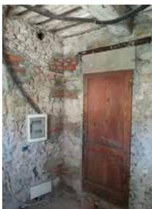
Fig. 7.1.2.3 - Connessione all'angolo, mediante intervento "scuci-cuci" Anghiari (AR) - Fonte: portale sismica Portos
