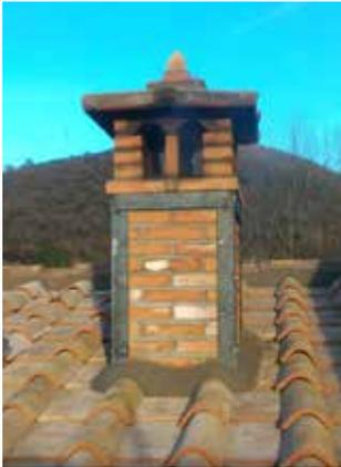
**Fig. 7.4.4 - Collegamento di camino in muratura, con elementi metallici
