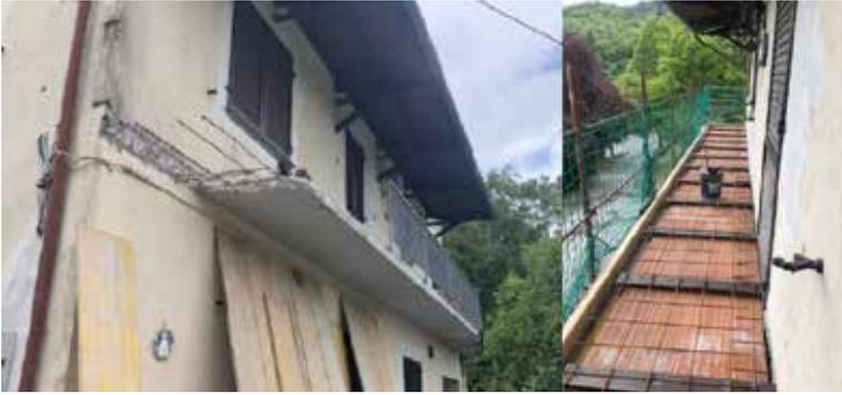
Fig. 7.4.13 - Demolizione di balcone pesante in soletta di c.a. e ricostruzione con struttura in acciaio
