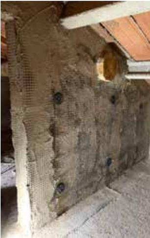
Fig. 7.1.3.1 - Collegamento tra paramenti murari, con materiali compositi
