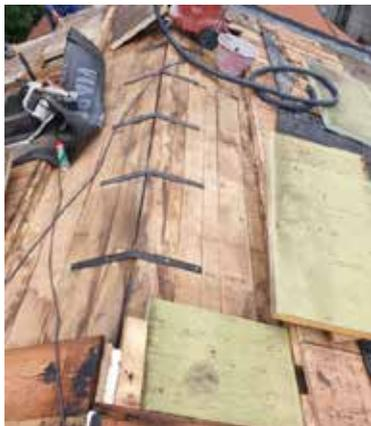
Fig. 7.1.1.50 - Collegamento di tavolato in legno a livello del colmo, mediante piatti metallici
