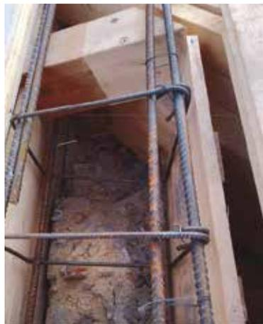
Fig. 7.1.2.54 - Cordolo in c.a. su muro perimetrale
