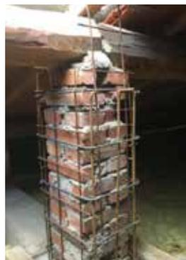
**Fig. 7.1.6.4 - Consolidamento di pilastro isolato in muratura, con betoncino armato**
