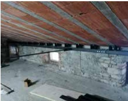
Fig. 7.1.2.52 - Cordolo in acciaio all'imposta di copertura spingente
