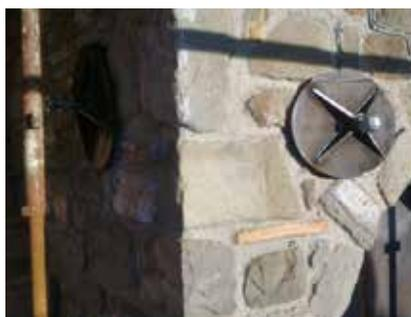
**Fig. 7.1.2.21 - Alloggiamento di piastre capochiave a collegamento tra pareti ortogonali**
