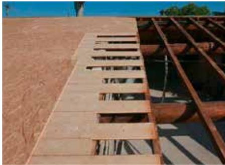
Fig. 7.1.1.28 - Irrigidimento di falda di copertura, con doppio tavolato in legno incrociato
