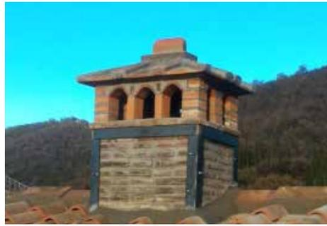
**Fig. 7.4.5 - Collegamento di camino in muratura, con elementi metallici
