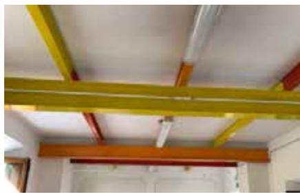
Fig. 7.1.1.12 - Rinforzo flessionale di solaio, con travi in acciaio rompitratta
