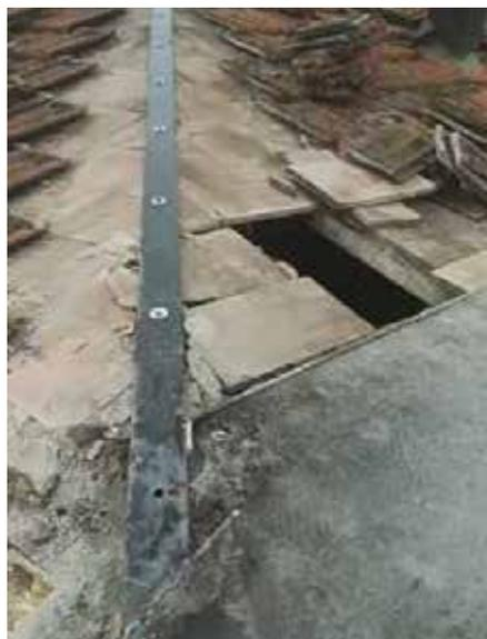
Fig. 7.1.2.46 - Cordolo in acciaio sul displuvio di falda
