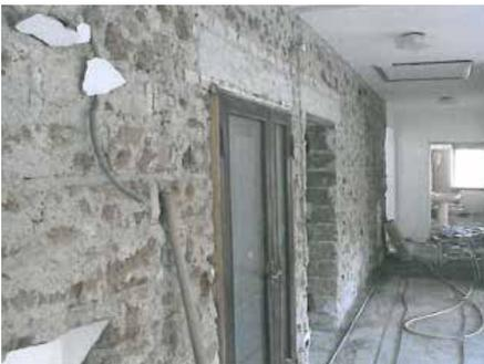
Fig. 7.1.4.5 - Consolidamento parete, con betoncino armato e rete elettrosaldata (prima)
