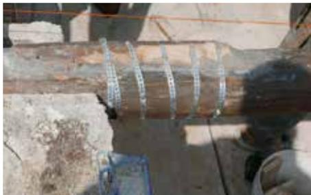
Fig. 7.1.1.30 - Rinforzo di trave in legno, con fascette metalliche di contenimento
