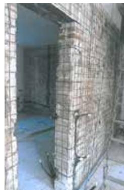
Fig. 7.1.4.6 - Consolidamento parete, con betoncino armato e rete elettrosaldata (dopo)
