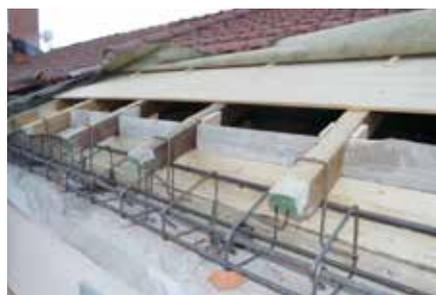
Fig. 7.1.2.55 - Cordolo in c.a. su muro perimetrale
