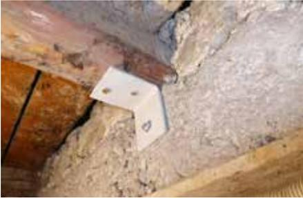
Fig. 7.1.1.5 - Collegamento di trave in legno alla muratura, con angolare metallico
