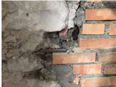
**Fig. 7.1.4.16 - Particolare barra di ancoraggio**
