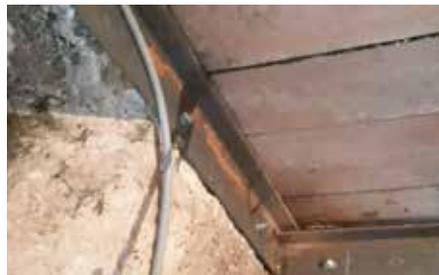
Fig. 7.1.1.10 - Collegamento di solaio alle murature d'ambito, con angolari metallici
