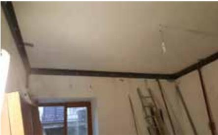
Fig. 7.1.1.7 - Collegamento di solaio alle murature d'ambito, con angolari metallici
