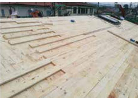
**Fig. 7.1.1.38 - Irrigidimento di copertura in legno, con doppio tavolato in legno incrociato Sansepolcro (AR) - Fonte: portale sismica Portos**
