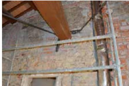
Fig. 7.1.1.49 - Collegamento dei tiranti metallici alle murature d'estremità
