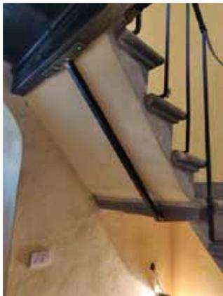
Fig. 7.1.6.7 - Rinforzo di scala, con elementi metallici
