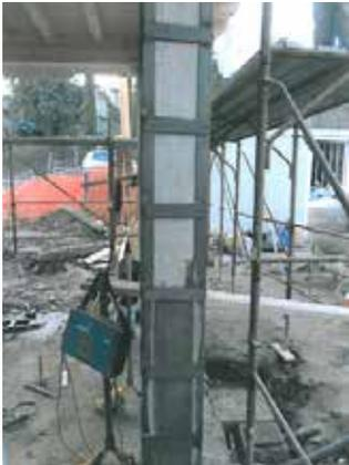
Fig. 7.2.1 - Consolidamento di pilastro in c.a., con angolari metallici e calastrelli
