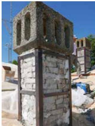
Fig. 7.4.8 - Collegamento di camino in muratura, con elementi metallici (estradosso copertura)
