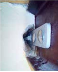
Fig. 7.1.1.3 - Collegamento di trave in ferro alla muratura perimetrale, con piatto metallico
