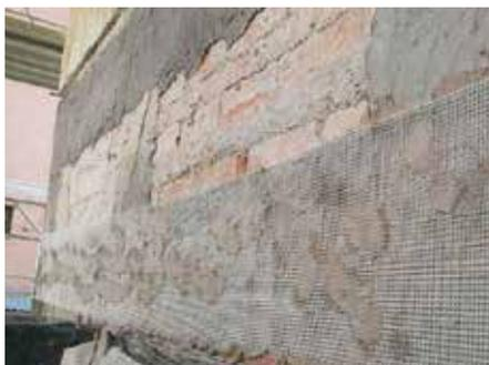
Fig. 7.1.4.9 - Consolidamento parete, con fibre in materiale composito
