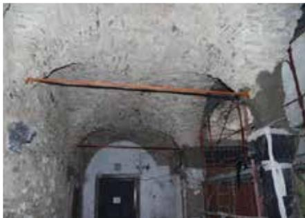
Fig. 7.1.5.3 - Inserimento di tiranti metallici nelle volte Pontremoli (MS) - Fonte: portale sismica Portos
