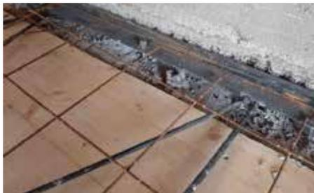
**Fig. 7.1.1.20 - Irrigidimento di solaio, con getto di cls alleggerito e rete elettrosaldata Sestino (AR) - Fonte: portale sismica Portos**
