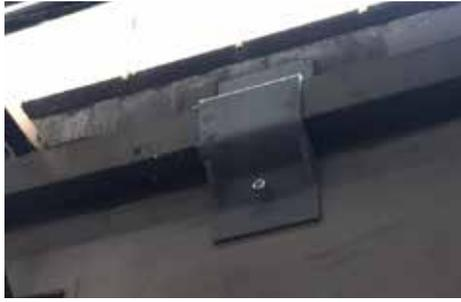
**Fig. 7.4.3 - Collegamento dei pannelli di tamponatura alla struttura principale di cagnone prefabbricato
