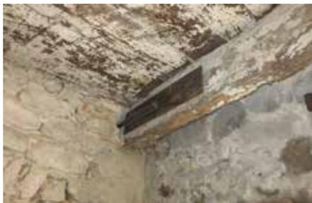
Fig. 7.1.1.1 - Collegamento di trave in legno alla muratura perimetrale, con piatto metallico
