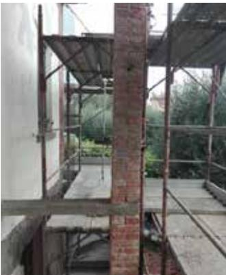
Fig. 7.1.6.1 - Consolidamento di pilastro in muratura (prima)
