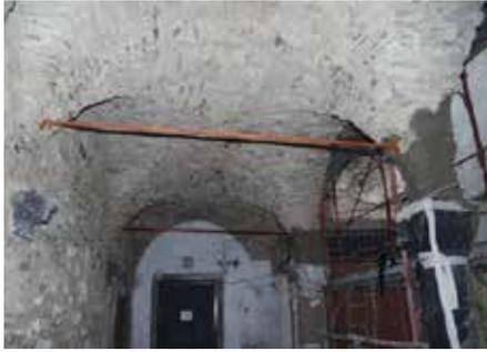
Fig. 7.1.5.5 - Consolidamento di arco, con nuova mazzetta di appoggio in muratura e betoncino armato
