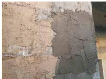
Fig. 7.1.4.10 - Consolidamento parete, con fibre in materiale composito
