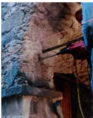
Fig. 7.1.5.1 - Perforazione per inserimento tirante Fivizzano (MS) - Fonte: portale sismica Portos
