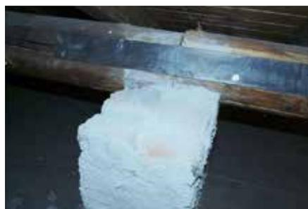
Fig. 7.1.1.53 - Collegamento tra orditure primarie all'appoggio dei timpani, mediante piatti metallici
