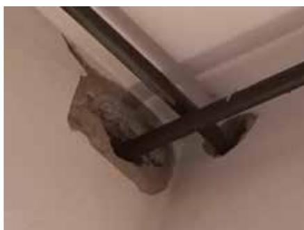
Fig. 7.1.2.31 - Alloggiamento nei fori di tiranti metallici tra due pareti ortogonali
