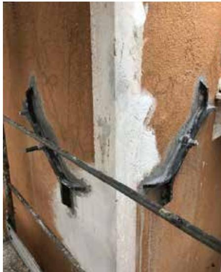
Fig. 7.1.2.26 - Alloggiamento di paletti capochiave a collegamento tra pareti ortogonali
