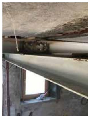
Fig. 7.1.1.14 - Rinforzo flessionale di solaio, con travi in acciaio rompitratta
