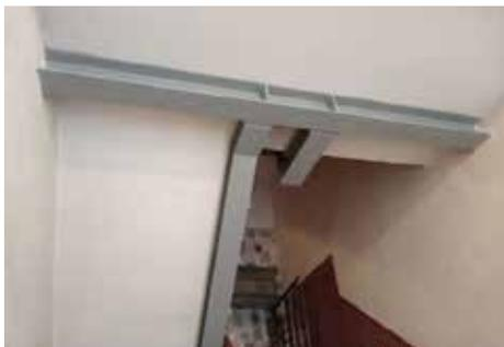
Fig.7.1.6.8 - Rinforzo di scala, con putrelle metalliche
