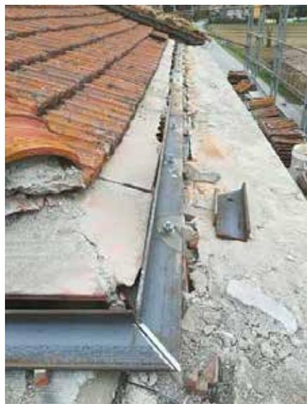
Fig. 7.1.2.47 - Cordolo in acciaio su muro perimetrale
