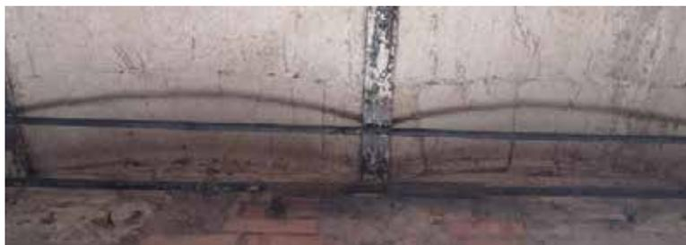
Fig. 7.1.1.33 - Collegamento dei profilati delle voltine, con saldatura di barre metalliche trasversali all'intradosso
