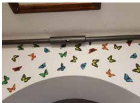
Fig. 7.1.2.32 - Particolare manicotto tenditore a collegamento tra due tiranti metallici
