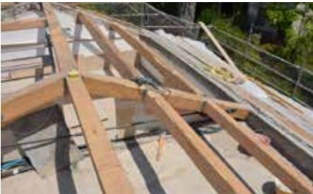
**Fig. 7.1.1.36 - Nuova copertura in legno a capanna e timpani rompitratta in muratura Anghiari (AR) - Fonte: portale sismica Portos**
