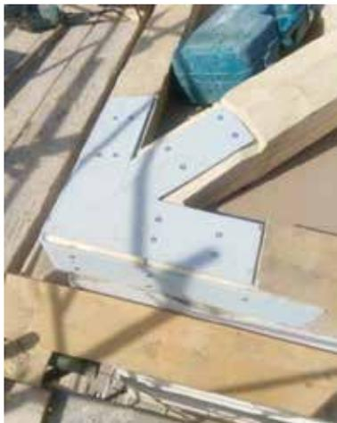
Fig. 7.1.1.40 - Collegamento di puntone alle travi d'ambito
