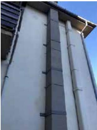
**Fig. 7.4.6 - Collegamento di canna fumaria all'edificio, con fasce metalliche
