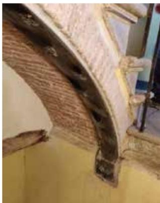
**Fig. 7.1.6.5 - Rinforzo di scala, con piatto metallico curvato**
