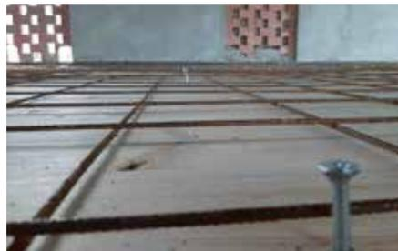
**Fig. 7.1.1.21 - Irrigidimento di solaio, con getto di cls alleggerito e rete elettrosaldata Sestino (AR) - Fonte: portale sismica Portos**
