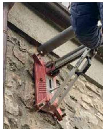
Fig. 7.1.2.14 - Perforazione muratura per inserimento tirante
