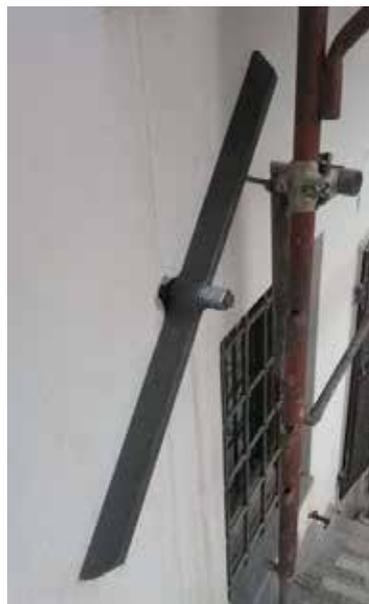
**Fig. 7.1.2.20 - Alloggiamento di paletto capochiave e chiusura con dado e controdado**
