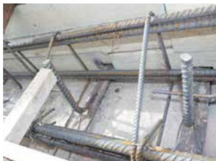
Fig. 7.1.2.56 - Cordolo in c.a. su muro perimetrale
