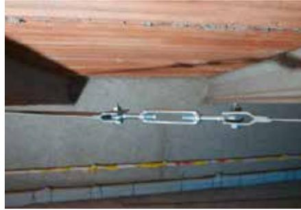
Fig. 7.1.1.27 - Irrigidimento di falda di copertura, con croci di S. Andrea (particolare manicotto)
