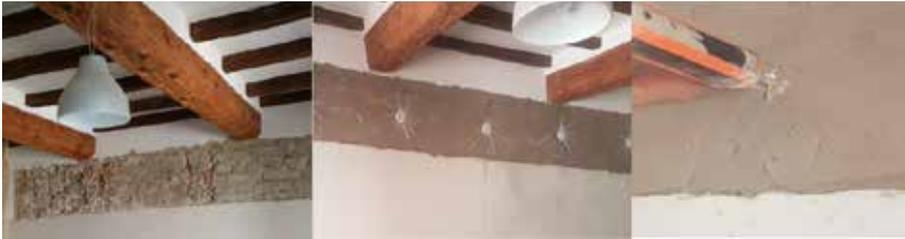
Fig. 7.1.2.35 - Placcaggio a livello di interpiano, con fasce in materiale composito
