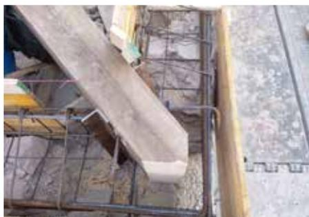
Fig. 7.1.1.42 - Collegamento di puntone al cordolo in c.a.
