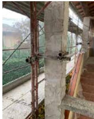
Fig. 7.1.6.2 - Consolidamento di pilastro in muratura, con fasce in materiale composito (dopo)
