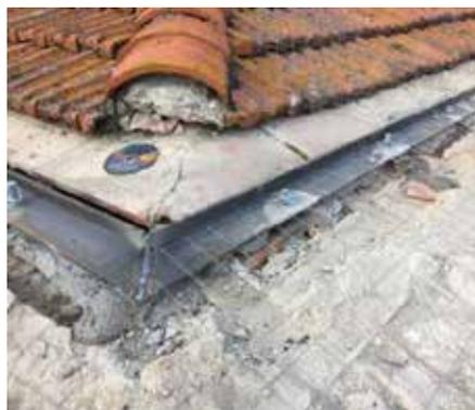
Fig. 7.1.2.48 - Cordolo in acciaio su muro perimetrale
