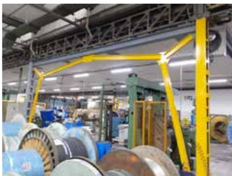
Fig. 7.3.1 -Rinforzo di telaio in acciaio, con idoneo controvento metallico
