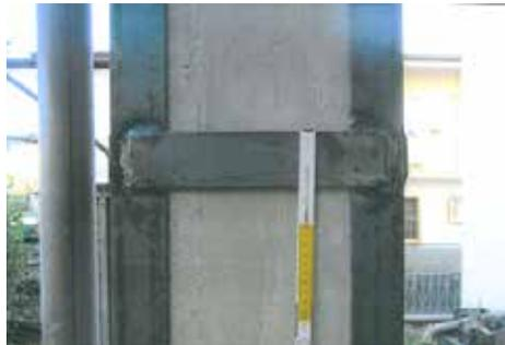
Fig. 7.2.2 - Consolidamento di pilastro in c.a., con angolari metallici e calastrelli
