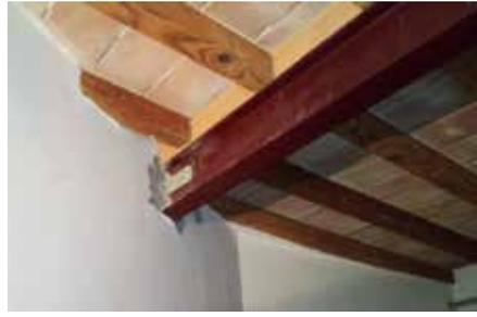
Fig. 7.1.1.4 - Collegamento di trave in ferro alla muratura perimetrale, con piatto metallico
