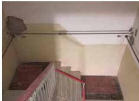
Fig. 7.1.2.28 - Tiranti metallici all'interno del vano scala
