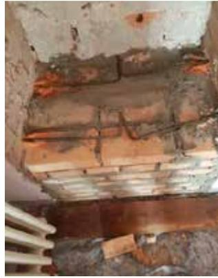
**Fig. 7.1.4.14 - Particolare barre di ancoraggio**
