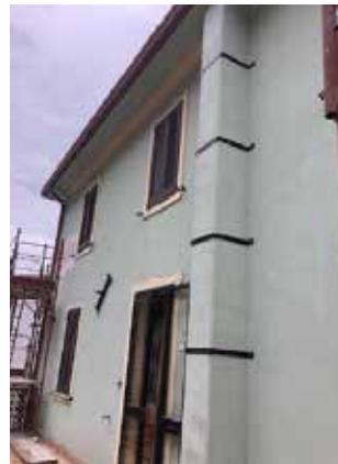
**Fig. 7.4.7 - Collegamento di canna fumaria all'edificio, con fasce metalliche
