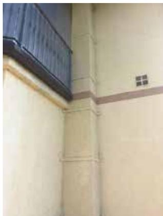
Fig. 7.4.10 - Collegamento di canna fumaria all'edificio, con fasce metalliche
