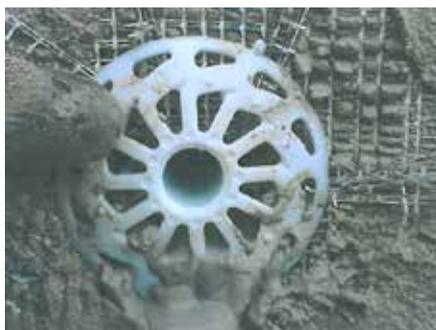
Fig. 7.1.2.45 - Particolare di inghisaggio del connettore Scarperia e San Piero (FI) - Fonte: portale sismica Portos
