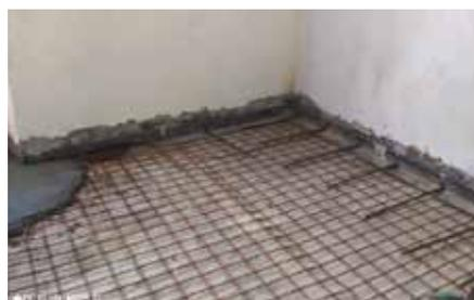
**Fig. 7.1.1.23 - Irrigidimento di solaio, con getto di cls alleggerito e rete elettrosaldata Sansepolcro (AR) - Fonte: portale sismica Portos**
