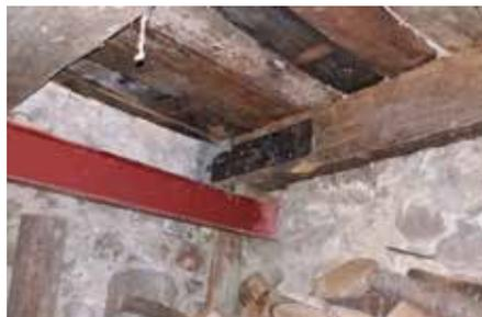
Fig. 7.1.1.2 - Collegamento di trave in legno alla muratura perimetrale, con piatto metallico
