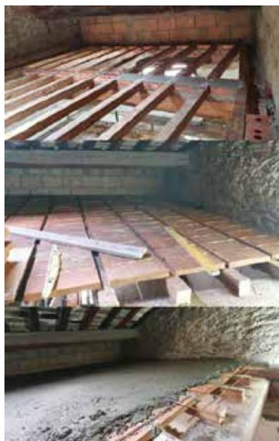
**Fig. 7.1.1.24 - Nuovo solaio di sottotetto in legno, pianelle in cotto e getto in cls alleggerito con rete elettrosaldata Sansepolcro (AR) - Fonte: portale sismica Portos**
