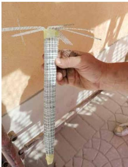
Fig. 7.1.2.42 - Particolare del connettore Sansepolcro (AR) - Fonte: portale sismica Portos
