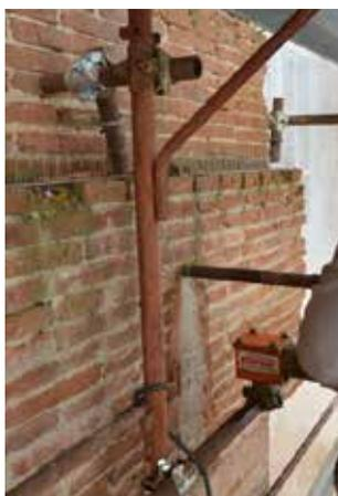
Fig. 7.1.2.13 - Perforazione muratura per inserimento tirante
