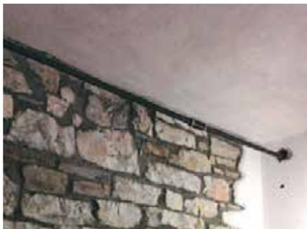
Fig. 7.1.2.27 - Tirante metallico all'interno del vano
