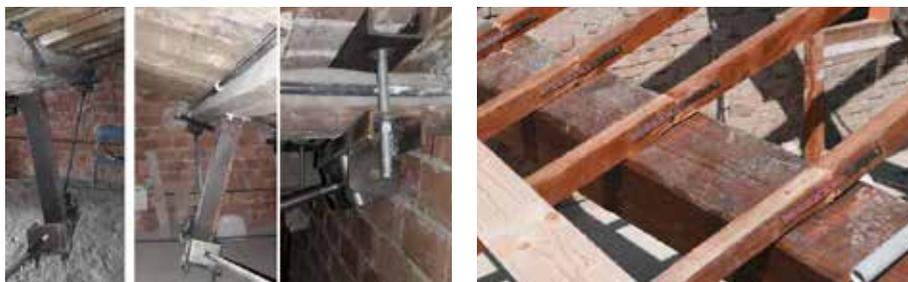
Fig. 7.1.1.57 - Riduzione di inflessione del colmo della copertura, mediante tirantature metalliche "reticolari"
