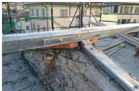
Fig. 7.1.1.54 - Collegamento del colmo ai timpani murari, mediante piastrine metalliche
