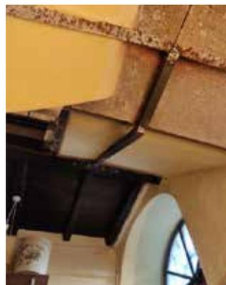
**Fig. 7.1.6.6 - Rinforzo di scala, con elementi metallici**
