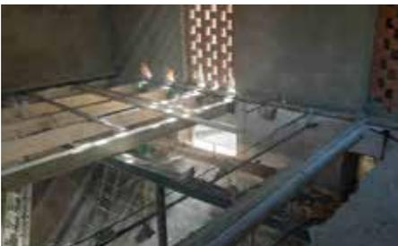
**Fig. 7.1.1.18 - Irrigidimento di solaio, con getto di cls alleggerito e rete elettrosaldata**
