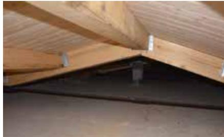
**Fig. 7.1.1.35 - Nuova copertura in legno, e catene metalliche con effetto "capriata" Anghiari (AR) - Fonte: portale sismica Portos**
