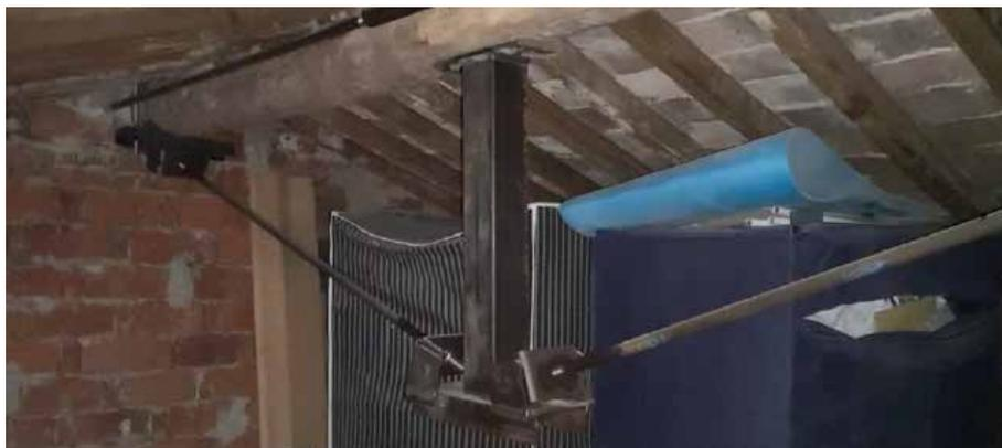
Fig. 7.1.1.56 - Riduzione di inflessione del colmo della copertura, mediante tirantature metalliche "reticolari"
