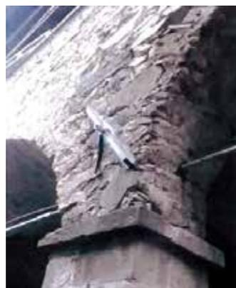
Fig. 7.1.5.2 - Inserimento di tiranti metallici nell’arco, nelle due direzioni Fivizzano (MS) - Fonte: portale sismica Portos
