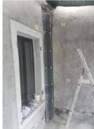
Fig. 7.1.2.8 - Connessione all'angolo, mediante angolari metallici - dopo
