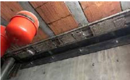
Fig. 7.1.1.9 - Collegamento di solaio alle murature d'ambito, con angolari metallici
