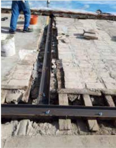
Fig. 7.1.2.50 - Cordolo in acciaio su muro di spina
