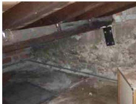
Fig. 7.1.1.51 - Collegamento di trave primaria alle murature perimetrali e all'orditura secondaria, mediante angolari metallici
