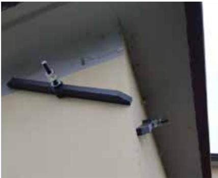
Fig. 7.1.2.25 - Alloggiamento di paletti capochiave a collegamento tra pareti ortogonali
