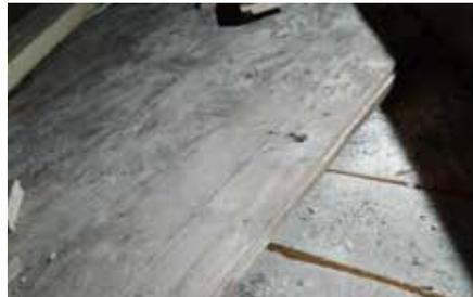
**Fig. 7.1.1.17 - Irrigidimento di solaio in legno, con doppio tavolato alternato**
