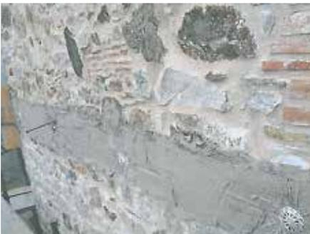
Fig. 7.1.2.36 - Placcaggio interpiano, con fasce in materiale composito
