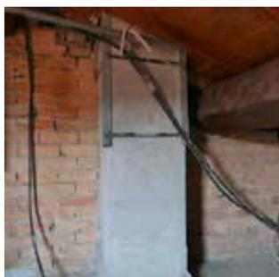
Fig. 7.4.12 - Collegamento di canna fumaria, con elementi metallici
