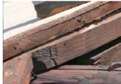
Fig. 7.1.1.29 - Irrigidimento di falda di copertura, con doppio tavolato in legno incrociato
