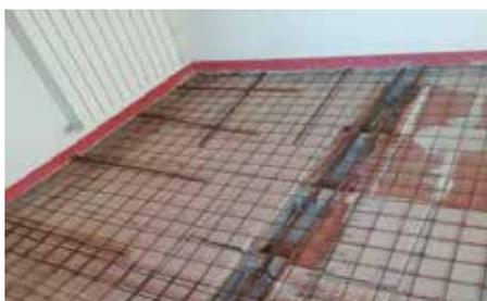
**Fig. 7.1.1.22 - Irrigidimento di solaio, con getto di cls alleggerito e rete elettrosaldata Rufina (FI) - Fonte: portale sismica Portos**
