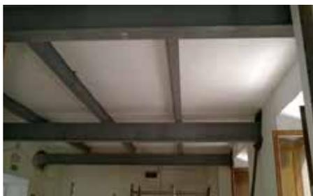
Fig. 7.1.1.11 - Rinforzo flessionale di solaio, con travi in acciaio rompitratta
