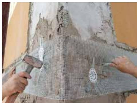
Fig. 7.1.2.2 - Connessione di cantonale, mediante rete in fibra di materiale composito Sansepolcro (AR) - Fonte: portale sismica Portos
