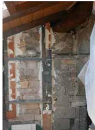
Fig. 7.4.9 - Collegamento di camino in muratura, con elementi metallici (intradosso copertura)
