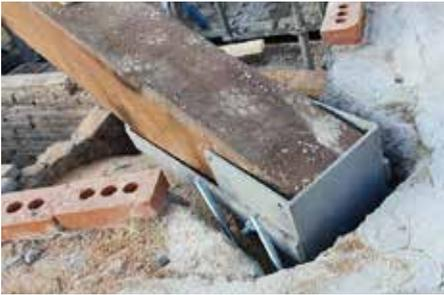
Fig. 7.1.1.46 - Collegamento di puntone alle murature d'ambito
