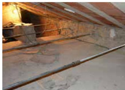
Fig. 7.1.1.43 - Riduzione della spinta dei travetti di copertura, con tiranti metallici effetto "capriata"
