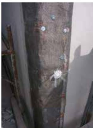
Fig. 7.1.2.1 - Connessione di cantonale, mediante rete in fibra di materiale composito Sansepolcro (AR) - Fonte: portale sismica Portos
