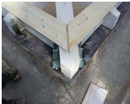
Fig. 7.1.1.41 - Collegamento di puntone alla muratura perimetrale
