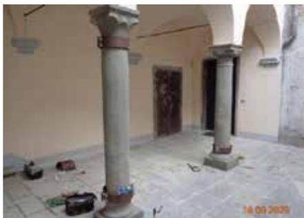
**Fig. 7.1.6.3 - Consolidamento di colonne in muratura, con fasce metalliche**
