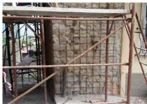
Fig. 7.1.2.4 - Connessione di cantonale, mediante betoncino armato con rete elettrosaldata Castelnuovo di Garfagnana (LU) - Fonte: portale sismica Portos
