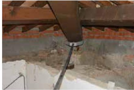
Fig. 7.1.1.47 - Collegamento di puntone alle murature d'ambito, con tiranti metallici
