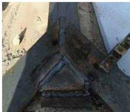
Fig. 7.1.2.49 - Cordolo in acciaio al colmo della copertura
