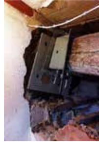
Fig. 7.1.1.6 - Collegamento di trave in legno alla muratura, con "bicchiere" metallico
