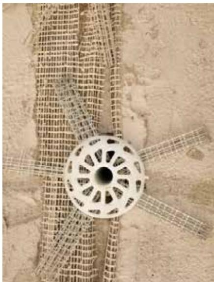
Fig. 7.1.2.43 - Particolare del connettore Sansepolcro (AR) - Fonte: portale sismica Portos
