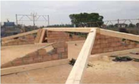
**Fig. 7.1.1.34 - Nuova copertura in legno a pagiglione e timpani rompitratta in muratura Cortona (AR) - Fonte: portale sismica Portos**
