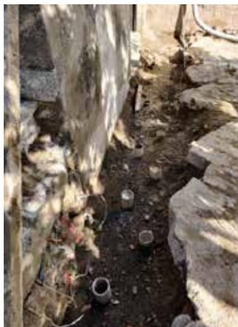
Fig. 7.1.6.11 - Consolidamento di fondazione, con realizzazione di micropali e cordolo in c.a. (scavo)
