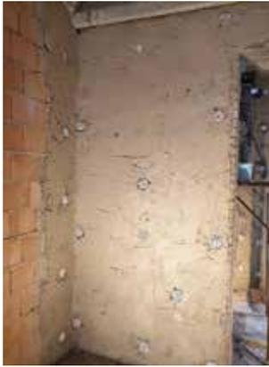
Fig. 7.1.2.5 - Connessione all'angolo, mediante rete in fibra di materiale composito
