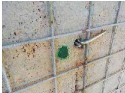
Fig. 7.1.4.8 - Consolidamento pareti, con betoncino armato (particolare connettore)
