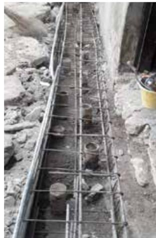
Fig. 7.1.6.12 - Consolidamento di fondazione, con realizzazione di micropali e cordolo in c.a. (armatura cordolo)
