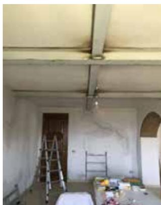
Fig. 7.1.1.13 - Rinforzo flessionale di solaio, con travi in acciaio rompitratta
