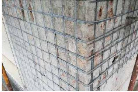
Fig. 7.1.2.6 - Connessione di cantonale, mediante betoncino armato con rete elettrosaldata
