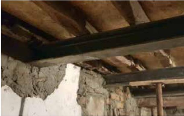
**Fig. 7.1.1.15 - Rinforzo flessionale di solaio, con travi in acciaio rompitratta**
