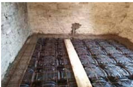
Fig. 7.1.6.10 - Consolidamento di fondazione e nuovo calpestio, con massetto ad "igloo"
