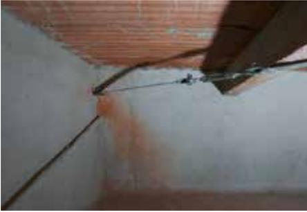
Fig. 7.1.1.26 - Irrigidimento di falda di copertura, con croci di S. Andrea
