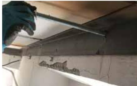
Fig. 7.1.1.8 - Collegamento di solaio alle murature d'ambito, con angolari metallici
