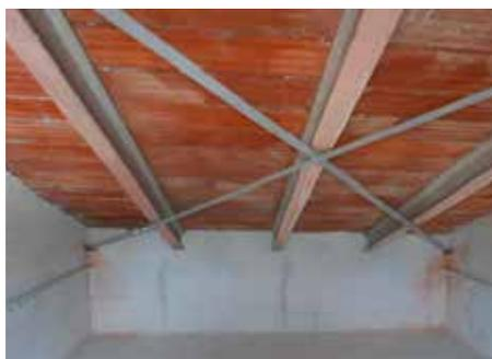
**Fig. 7.1.1.25 - Irrigidimento di falda di copertura, con croci di S. Andrea Sansepolcro (AR) - Fonte: portale sismica Portos**
