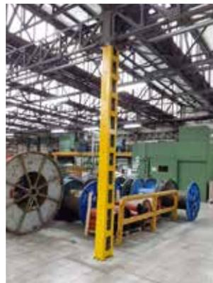
Fig. 7.3.2 - Rinforzo di pilastro in acciaio, con incamiciatura metallica e calastrelli
