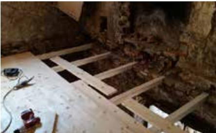
**Fig. 7.1.1.16 - Nuovo solaio in legno e tavolato di irrigidimento**
