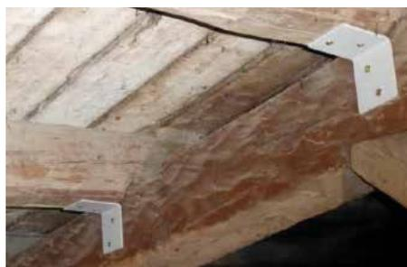
Fig. 7.1.1.52 - Collegamento di orditura primaria all'orditura secondaria, mediante angolari metallici
