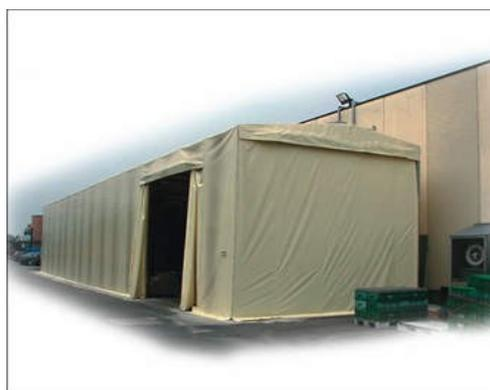
**R.** Se si tratta di strutture di modeste dimensioni ed in classe d’uso I (punto 2.4.2 delle NTC 2008) trattandosi di elementi mobili e coperti con manto in tessuto o materiale plastico, generalmente dotati di specifiche certificazioni dei vari componenti, senza rilevanza per la pubblica incolumità, si ritiene che possa essere omesso il deposito del progetto ai sensi dell'art. 93 del DPR 380/2001.
