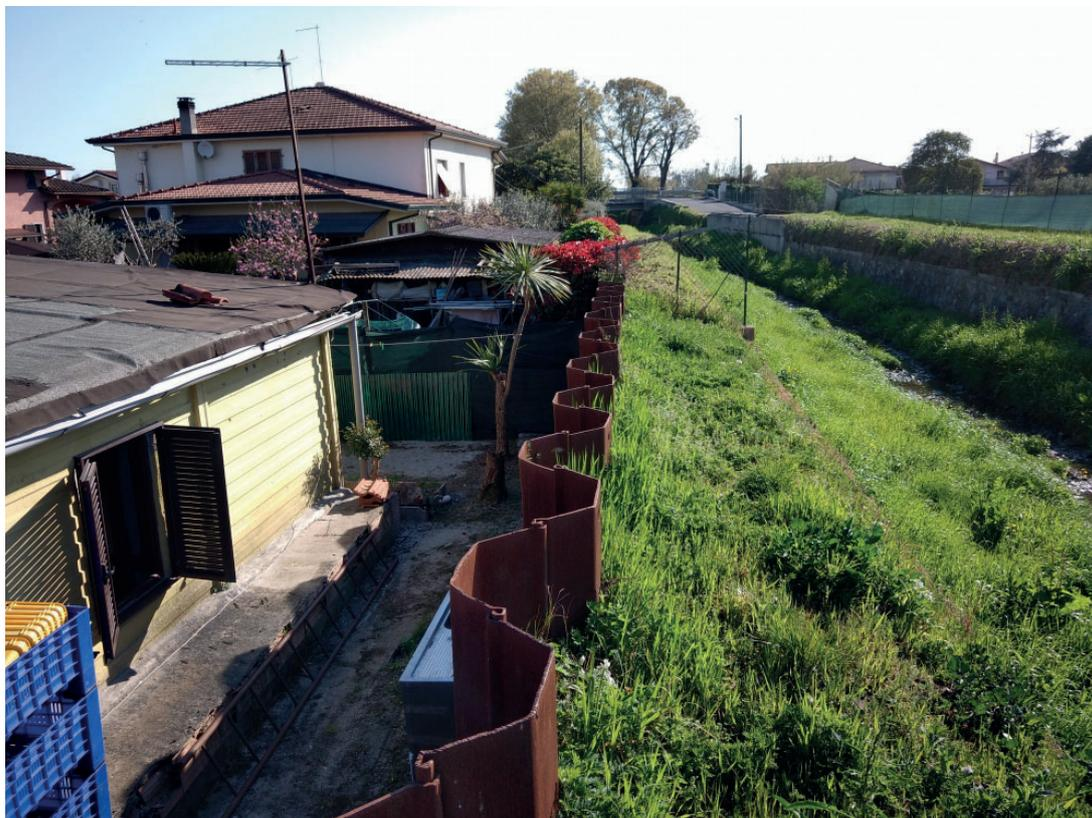
*Figura 2.5: vista dell'argine sinistro del Ricortola a monte di via Pietrasanta. Sono evidenti le palancole già esistenti ed i fabbricati posti in adiacenza del rilevato arginale, che verranno rimossi.*
